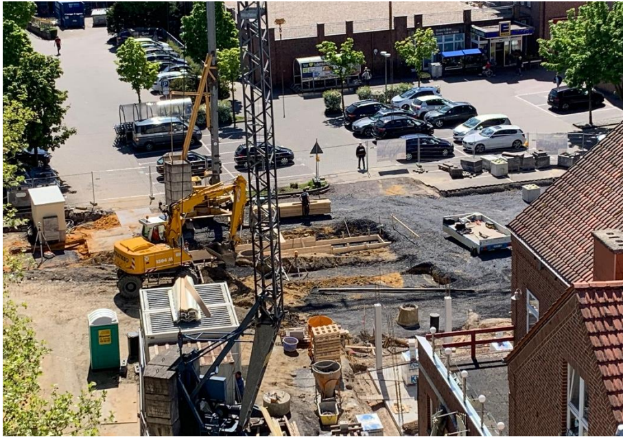
Baustelle Rathausparkplatz Foto: Stadt Billerbeck
