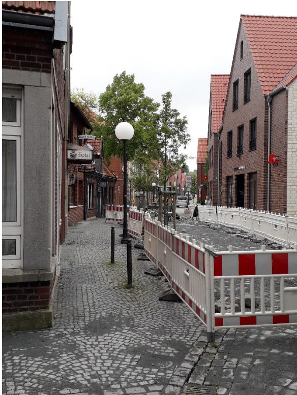
Baustelle Schmiedestraße – ist abgeschlossen Foto: Citymanagement Billerbeck
