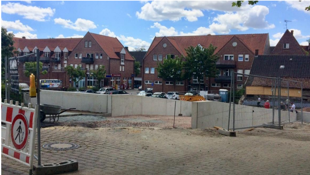
Baustelle Rathausparkplatz Foto: Citymanagement Billerbeck
