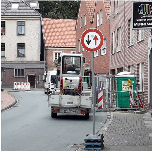
Die Baumaßnahme Lilienbeck hat begonnen (Foto: büro frauns)
