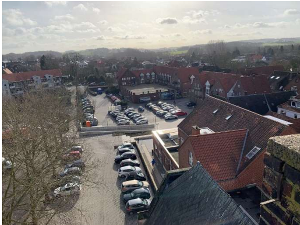
Der fertiggestellte Rathausparkplatz, Fotos: Stadt Billerbeck
