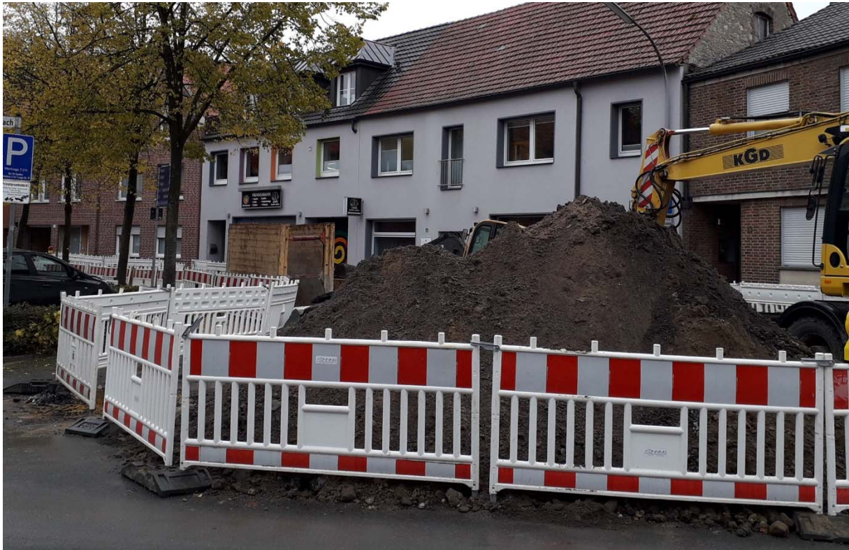
Die Baumaßnahme im Kreuzungsbereich Lilienbeck / Haulingbach (Foto: büro frauns)
