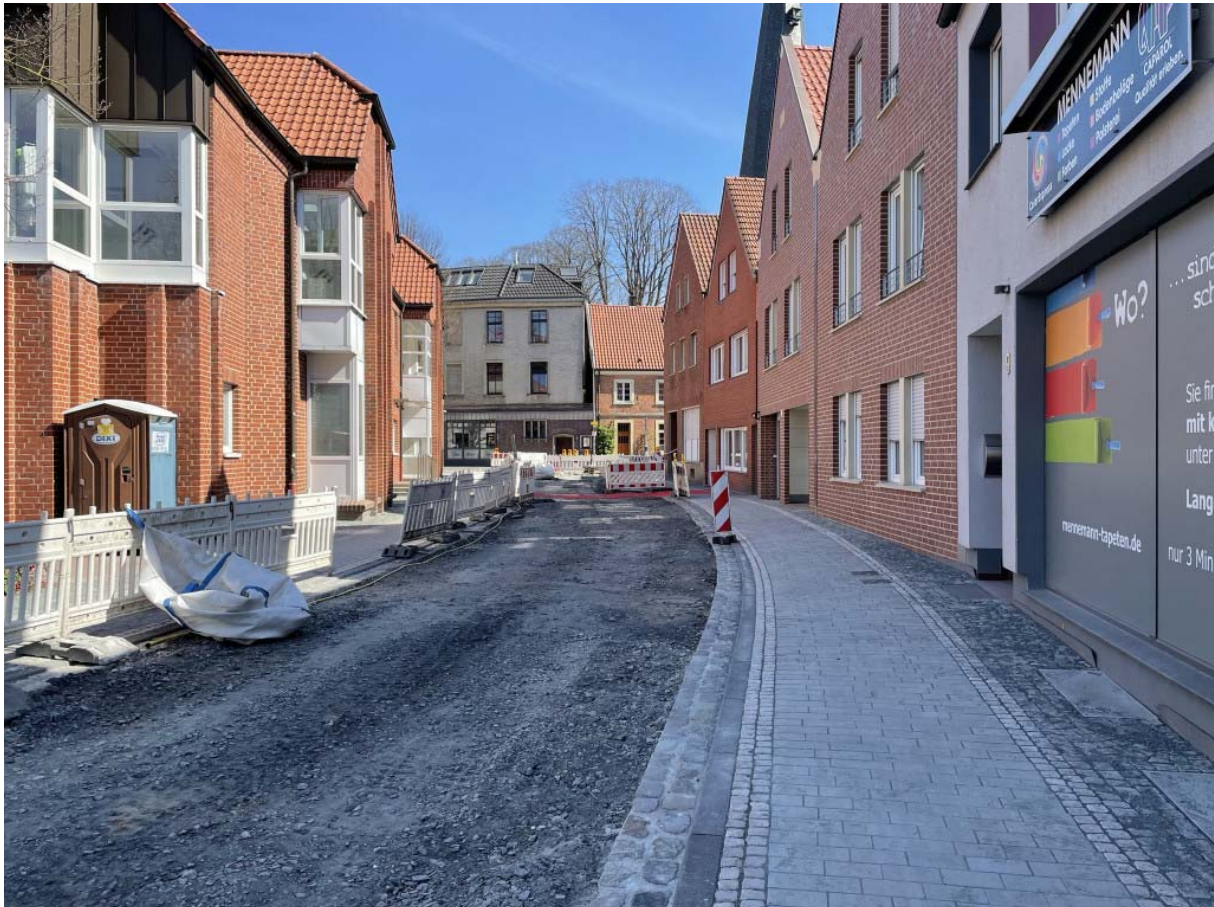
Neu gepflasterter Gehweg in der Lilienbeck (Foto: Stadt Billerbeck)
