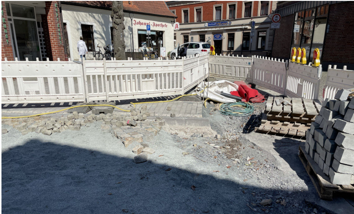
Pflasterarbeiten im Kreuzungsbereich Lilienbeck/ Coesfelder Straße/ Lange Straße (Foto: Stadt Billerbeck)
