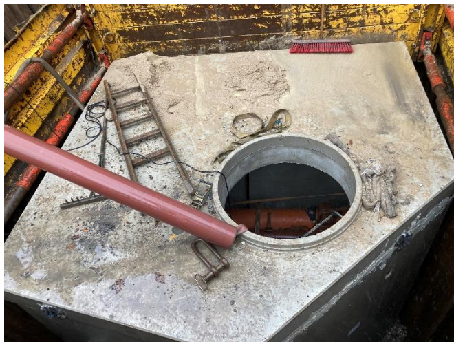
Eingesetzter Eckschacht für die Trennentwässerung, Mühlenstraße Ecke Hagen. Fotos: Citymanagement Billerbeck
