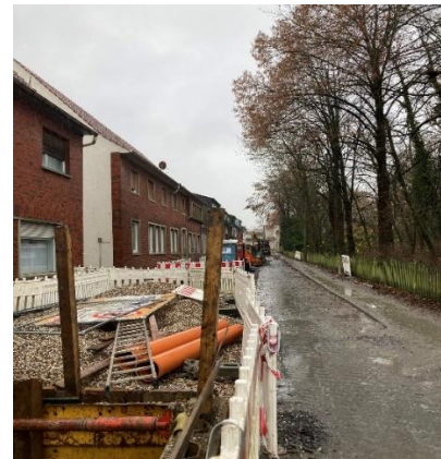
Kanalbauarbeiten untere Mühlenstraße (Foto: Citymanagement Billerbeck)
